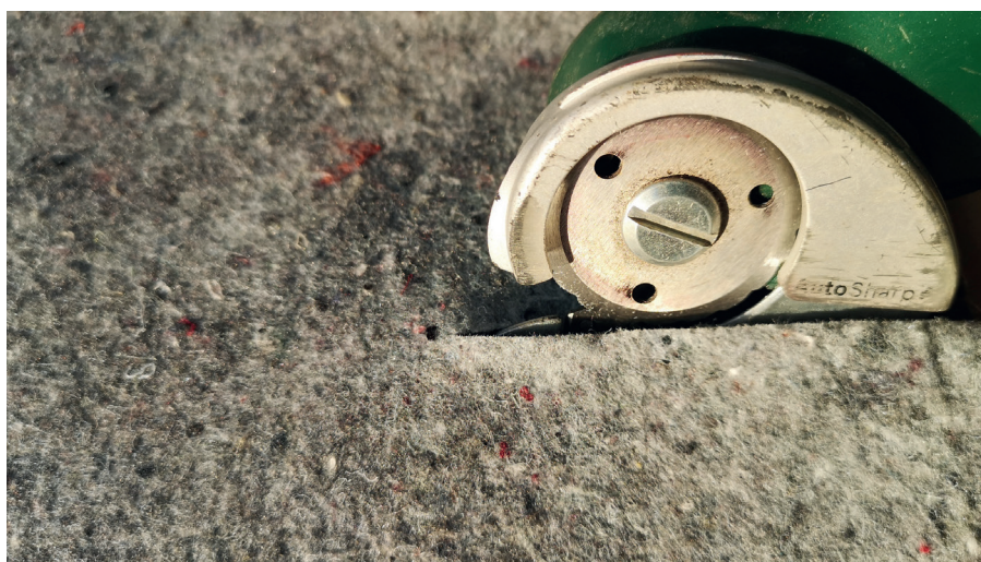
Fot. 3. Docinanie geowłókniny nożem krążkowym
