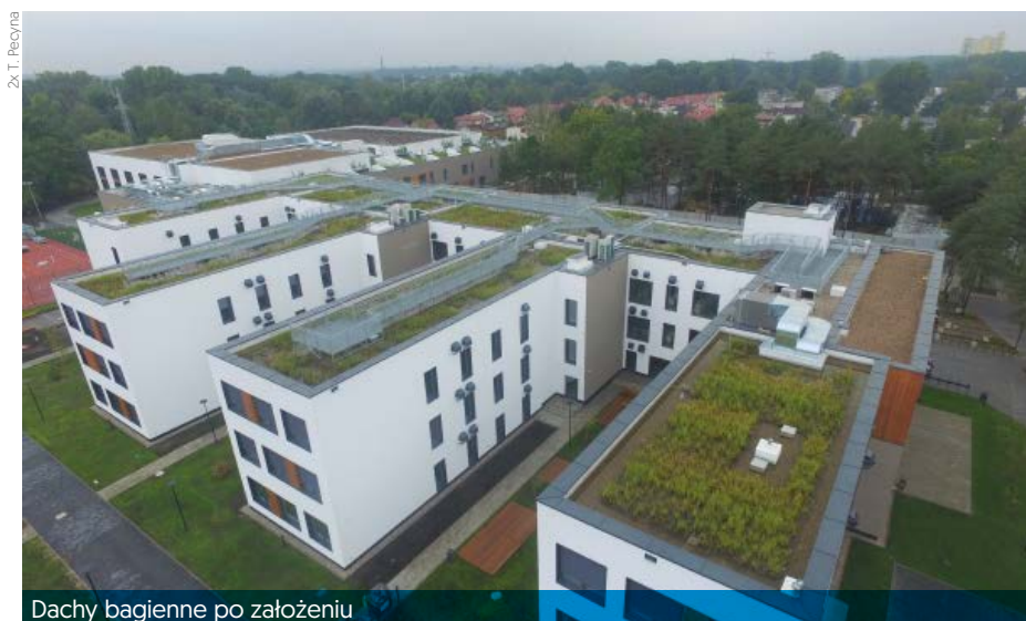
Dachy bagienne po założeniu
