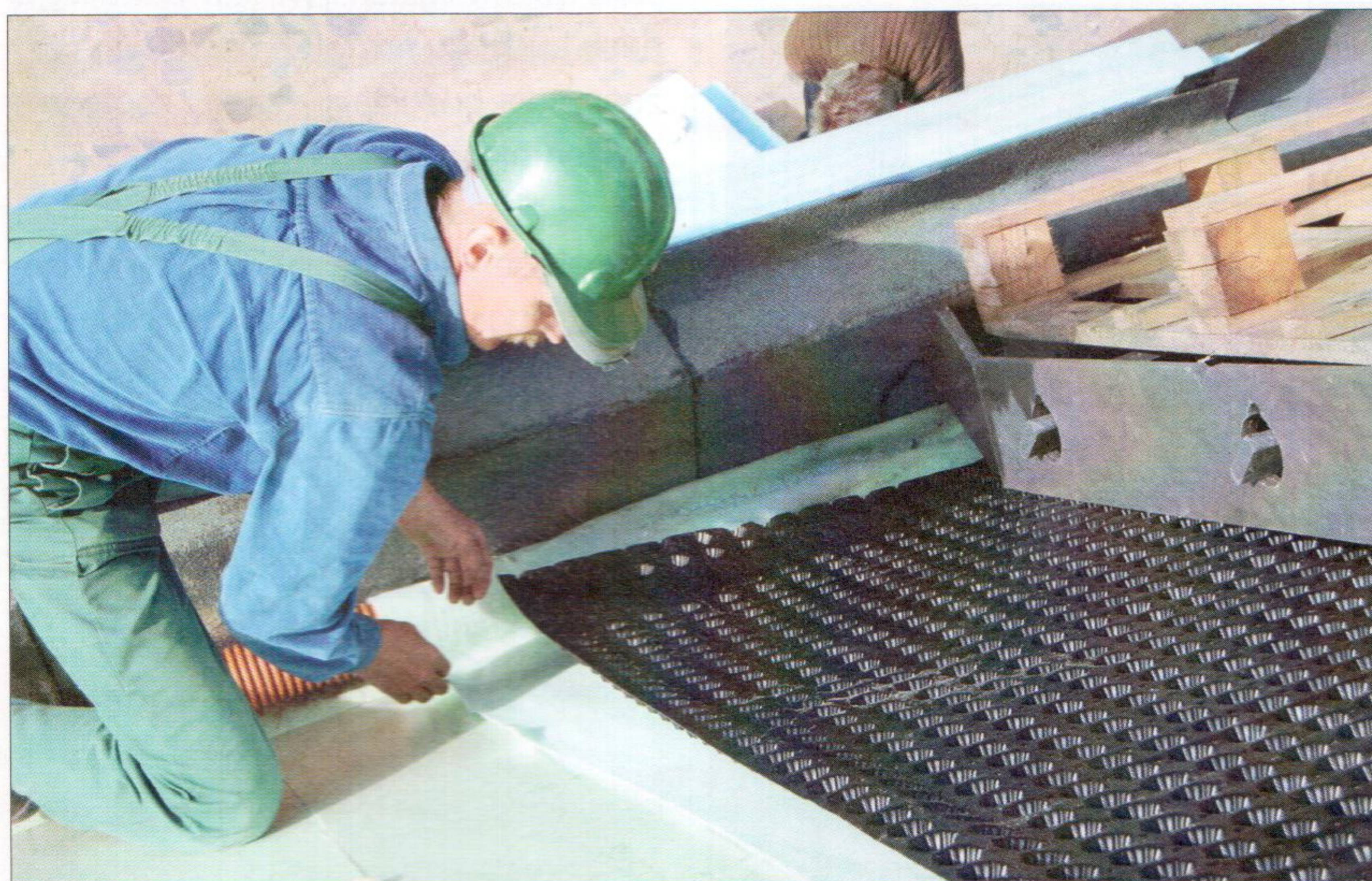
Fot. 2 | Dach zielony skośny na dachu odwróconym
