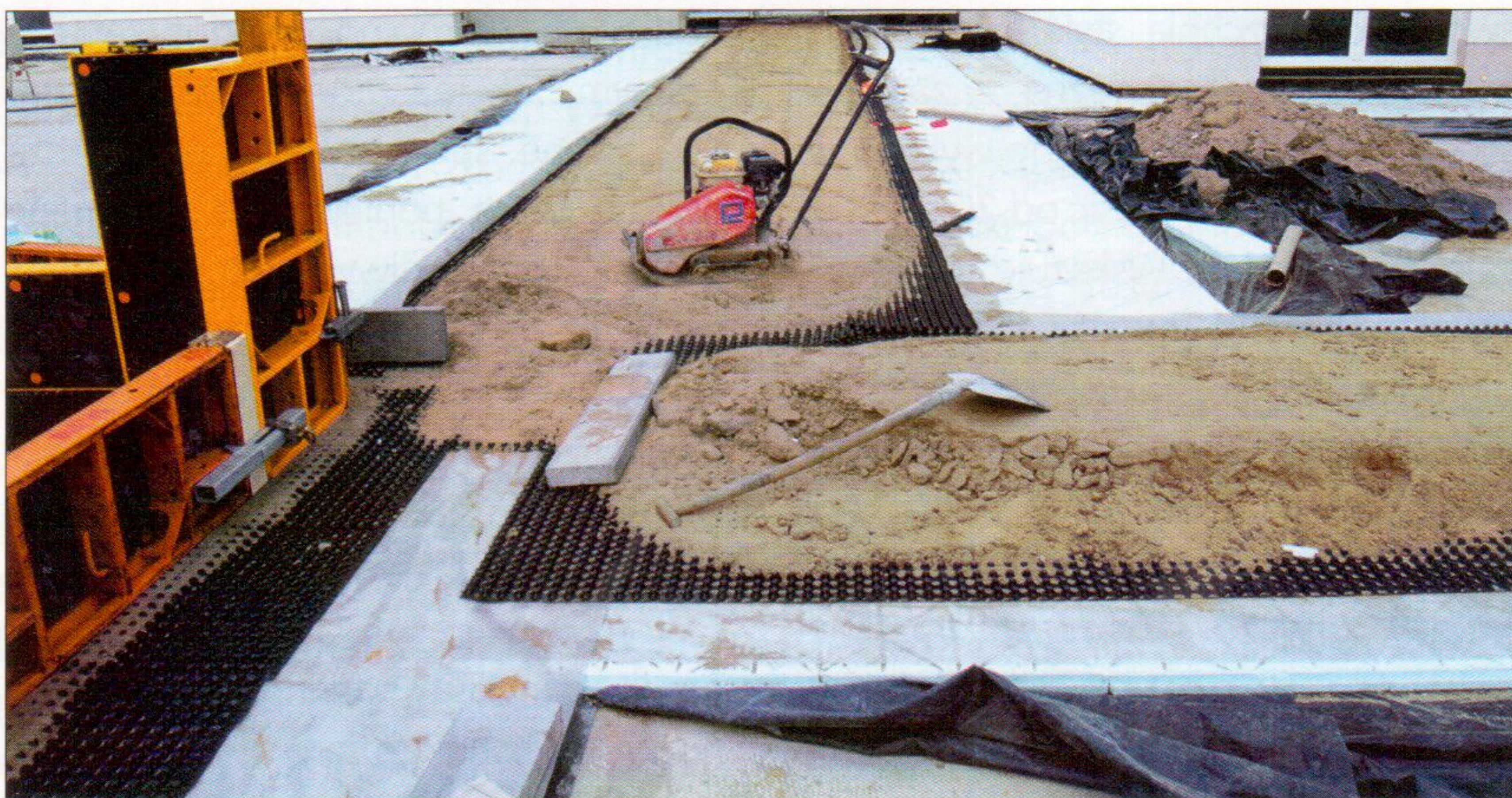
Fot. 3 | Wykonanie chodnika na dachu odwróconym
