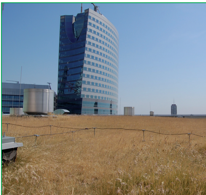
Dach ekstensywny na budynku Złote Tarasy w Warszawie. Fot. Paweł Kożuchowski
