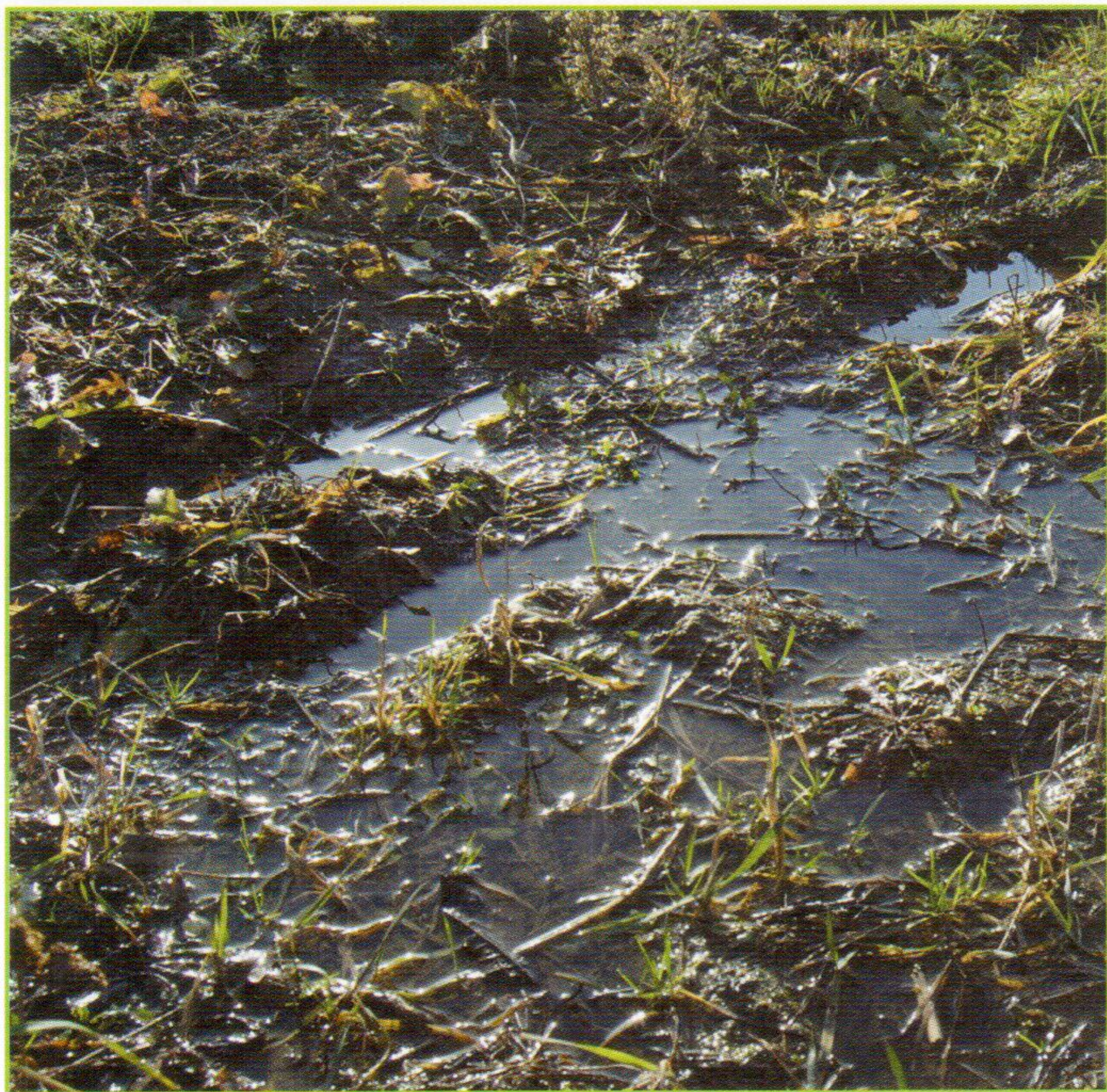
Zastoiny wody na dachu zielonym
