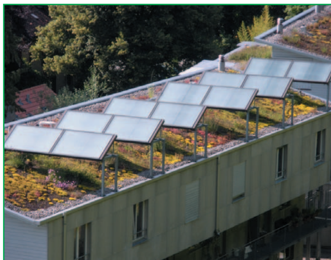
Dach zielony z zastosowaniem kolektorów słonecznych – typowy element niemieckiego krajobrazu. Źródło: www.flickr.com
